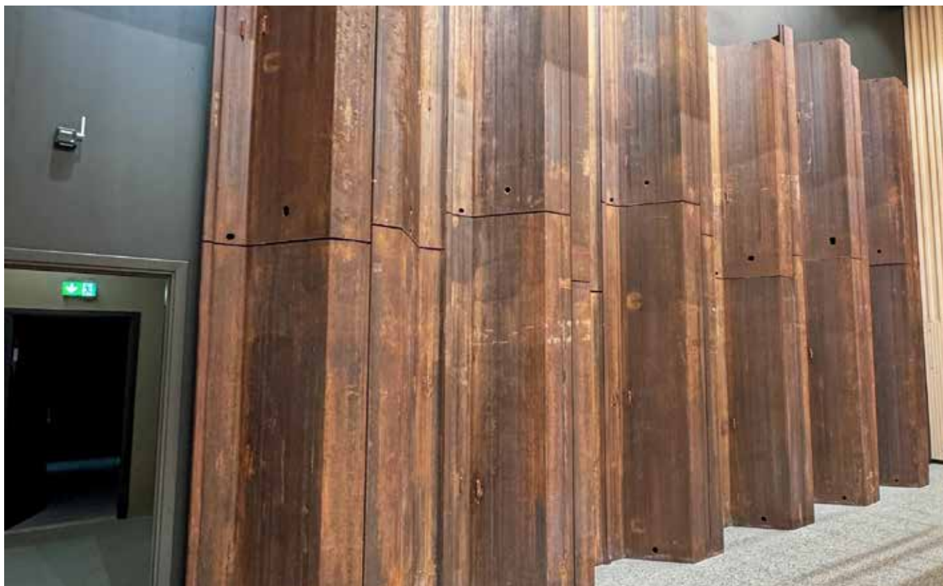
↑ Rester av stålpunten som er brukt som yttervegg i kjelleren av Construction City, står nå som en flott bakvegg i auditoriet.
