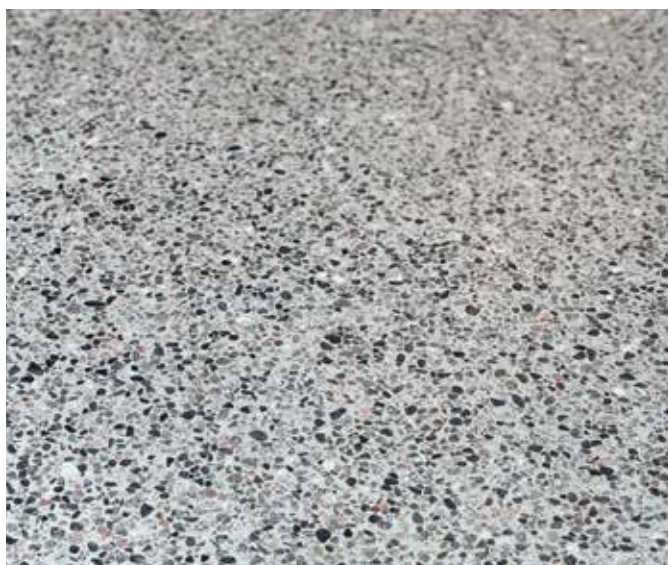
↑ 10 tonn slipestøv fra eksisterende gulv ble sugd opp og gjenbrukt som tilslag i ny terrazzo.
