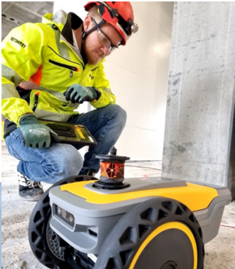
Innovasjonssjef Christopher Carlsen sjekker at alt er i orden med SitePrint-roboten. Foto: Betonmast
