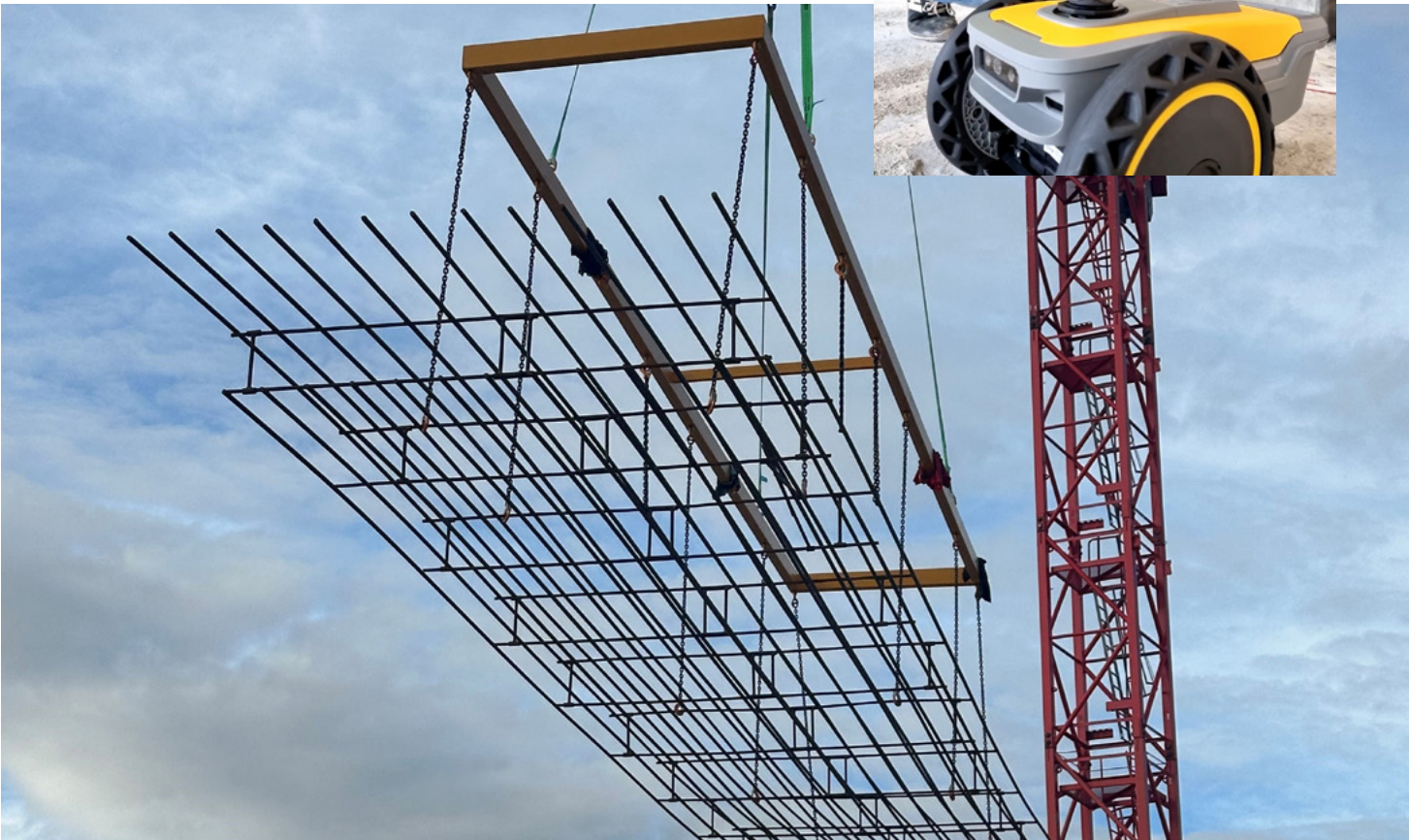
Et ferdig lagt armeringsgrid heises på plass på Tolvsrød Torg. Modulene er designet med en bredde på 2,40 meter, slik at de kan transporteres på en vanlig bil. Hovedmodulene er 12 meter lange og 2,4 meter brede. Ved at løsningen er sammenleggbart, reduseres transportbehov, ettersom man kan laste en bil med tilnærmet like mye stål som om man skulle fraktet løsjern. Dermed unngår man å frakte mye «luft», som var et problem tidligere. Modulen punktsettes på stedet på anleggsplassen før det heises på plass. Foto: Betonmast.
