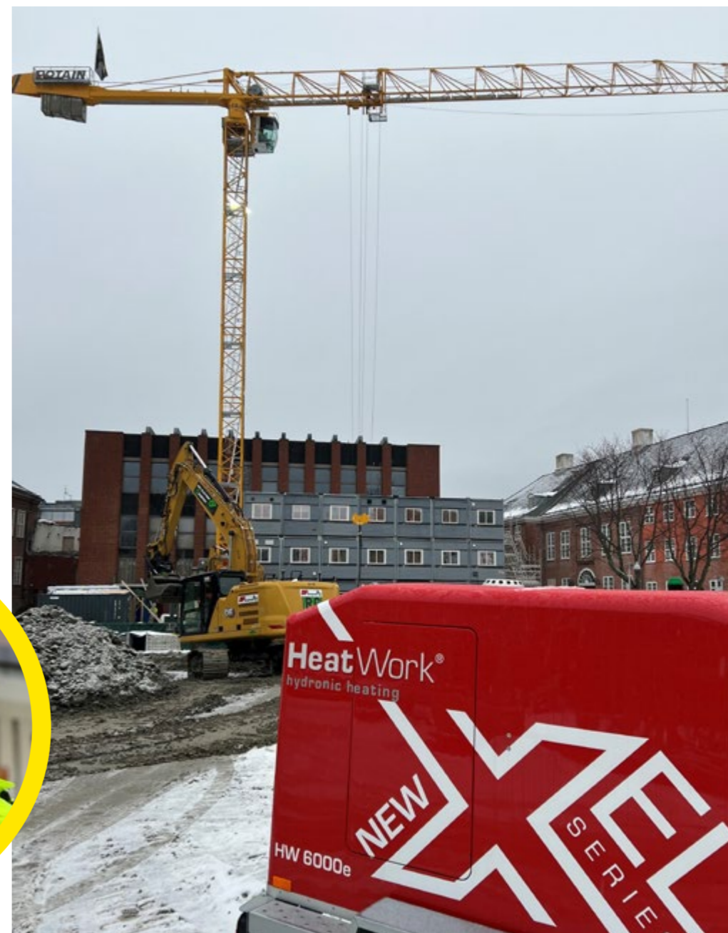
Selskapet HeatWork har utviklet et helt nytt varmeverk som går på strøm og som er tatt i bruk på Katta. Bransjen er avhengige at aktører som HeatWork utvikler og tilpasser produktene sine slik at vi får utslippsfrie alternativer til alle arbeidsoppgaver på en byggeplass. Foto: Betonmast
