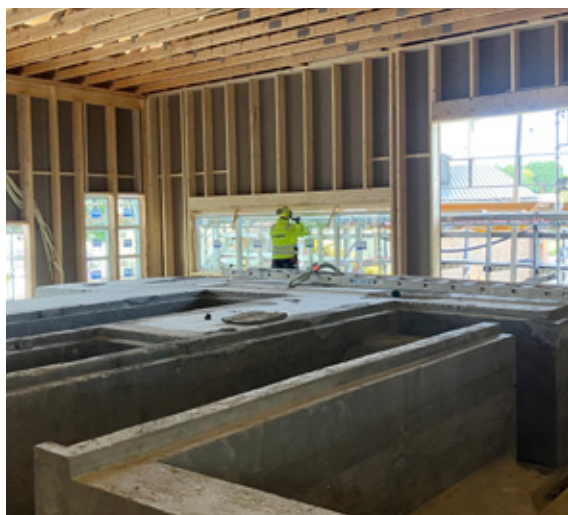
Skreia renseanlegg har bestått av utfordrende betongarbeider.
