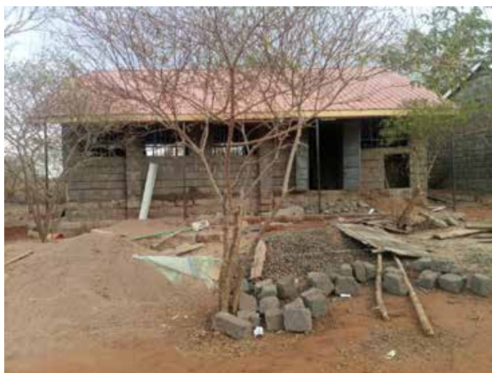
Bilder fra byggingen av den nye undervisningslabben på Edustep. Labben skal ha mange vasker og en del utstyr for å kunne brukes i kjemi-undervisning m.m.
