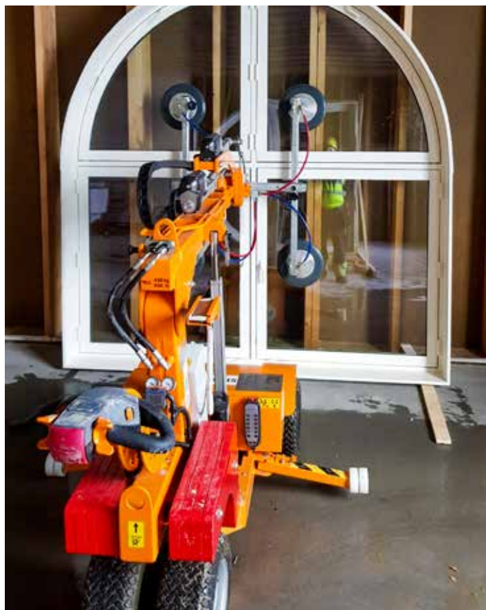
Ved å benytte glassmonteringslift unngås tunge løft. Her fra Skreia renseanlegg.
