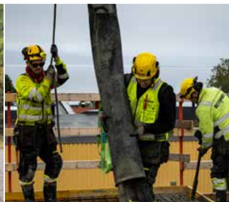
Inge Morten Braa, Emil Dullum og Reidar Aarhaug utfører dekkestøp på Reppetoppen. FOTO: KARIANNE BØRRESEN MOKSNES
