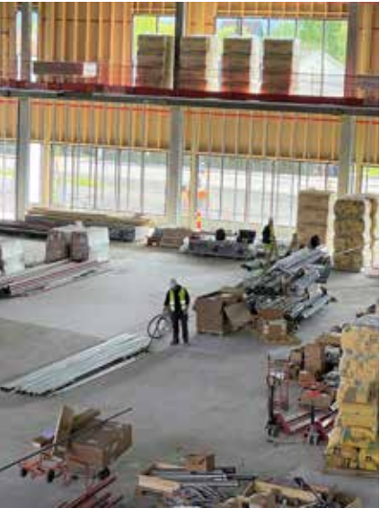
I den store flerbrukshallen er de ulike underentreprenørene tildelt egne soner for oppbevaring av utstyr og materiell. Her støvsuges gulvet. FOTO: NEDA BEYZAVI
