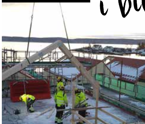
Heising og montering av taksperrer på det niende og siste bygget på Vollen Marina i Asker. FOTO: EIVIND SÆTHA
