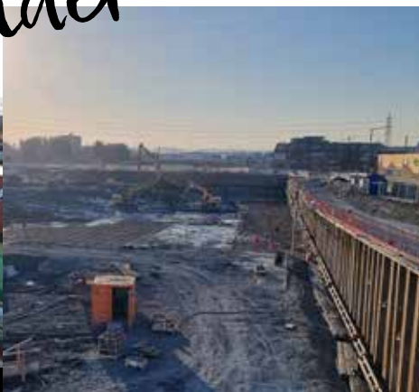
Byggegroppa på Construction City. FOTO: MORTEN LYGVED
