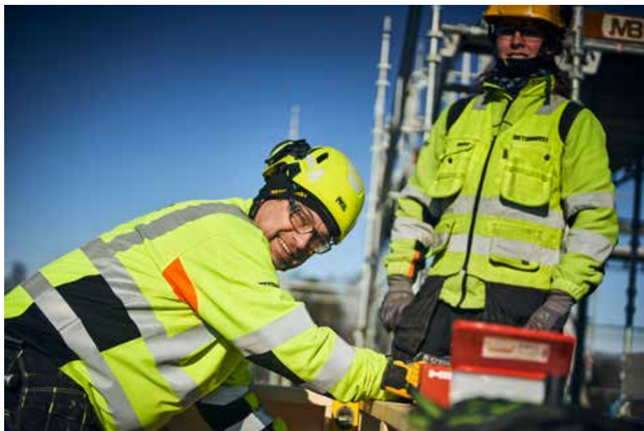
Cato Rundhaug og Sebastian Wilkinson Torget er tømrere på prosjekt Sollitunet på Hamar.
