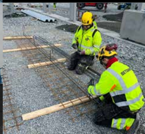
Betonggutta i aksjon på Infinitum i Trøndelag. FOTO: OLE JOHNNY FOSSEN
