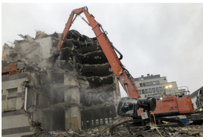
Sveriges högsta rivningsmaskin in action! Arbetet med att omvandla den gamla kontorsfastigheten Gladan 3 på Kungsholmen i Stockholm till 138 lägenheter är nu igång!
