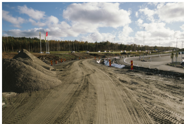
Betonmast Anläggning bygger om Hisingsleden i Göteborg. Arbetet är nu i full gång.
