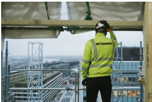
Betonmast Stockholm renoverar en av Hötorgsskraporna mitt i Stockholm city.
