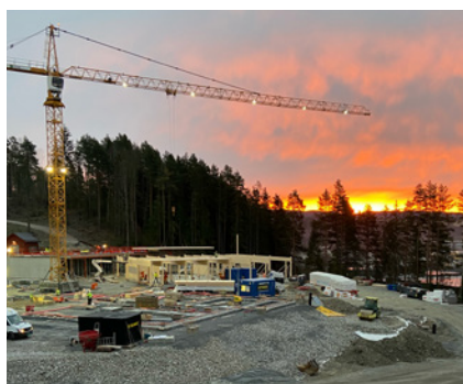
Tårnkran i soloppgang på Hov ungdomsskole. Foto: Magne Larsen
