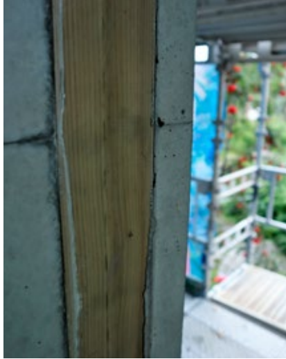
▲ Det er innfelt isolasjon i betongvegg-elementene, og blåseisolasjon der det er mulig i Fjæregata 1.
