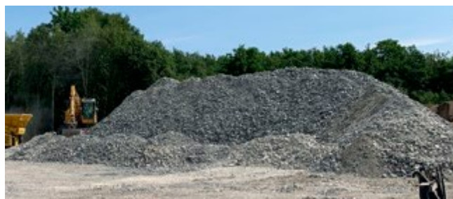
Gjenbruk av stedlige masser ved bruk av sorteringsverk på stedet sparte 16000 km med massetransport.
