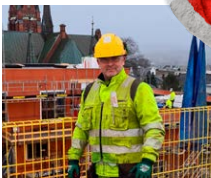
Betongarbeider Vidar Skipar på prosjekt Lietorvet i Skien. Foto: Hamed Hasan
