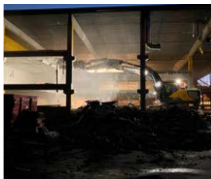
Riving må til. Fra Betonmast Romerikes prosjekt Per Krohgs vei 1 i Oslo
