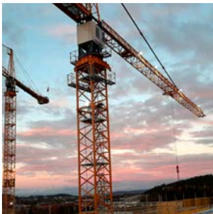
Tårnkraner kan absolutt være vakkert! Foto: Rafal Janik, Betonmast Boligbygg
