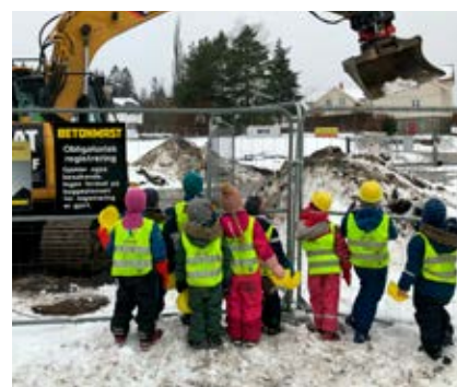
Barnehagebesøk på Moer sykehjem, Betonmast Østfold
