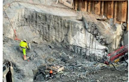
Betonmast Anläggning lägger grunden för ett av Göteborgs högsta hus. Här ser du hur de borrat med tätsöm och spräckt berget med Darda och snigeldynamit för att få till en rak och jämn vägg.
