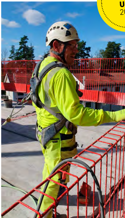
Personlig fallsikringsutstyr er en selvfølge på alle våre byggeplasser. Her fra Tangen senter.
