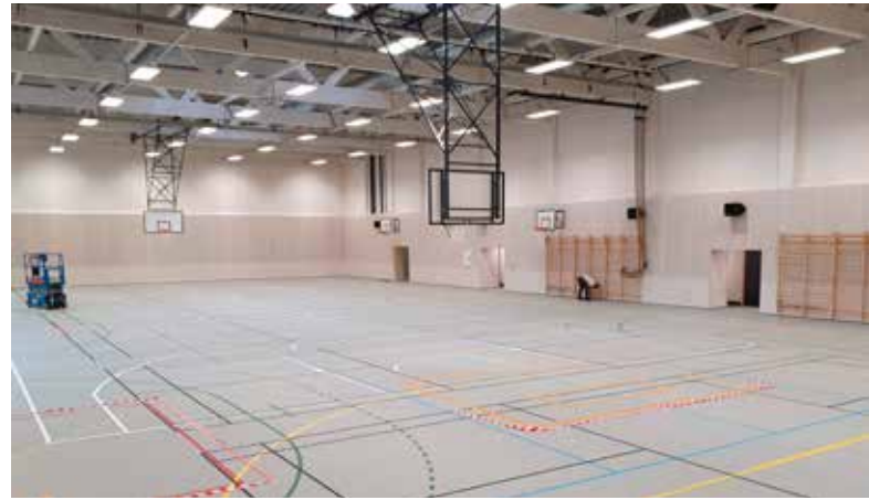
Til idrettshallen ble det levert 9 meter høye vegger, og dragerne var på hele 27 meter.
