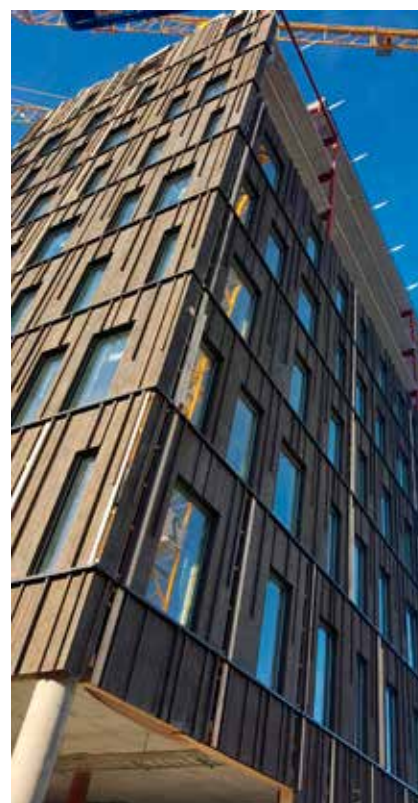
I disse dager pågår montasje av fasadelementer på DBC i Drammen for fullt, 2-3 semitrailere daglig.
