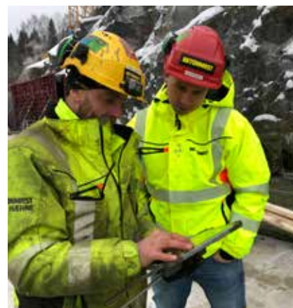
Betongfagarbeider Janis Tjarve viser prosjektleder Håvard Henriksen hvor enkelt han finner riktig tegning.
